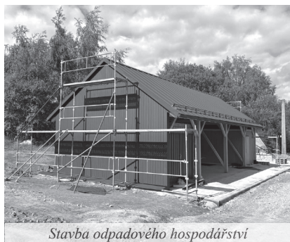
Stavba odpadového hospodářství
