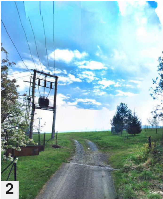
Fotodokumentace ↑ Příjezd po hlavní komunikaci ↓ Hlavní příjezd k lokalitě nově určené k zástavbě
