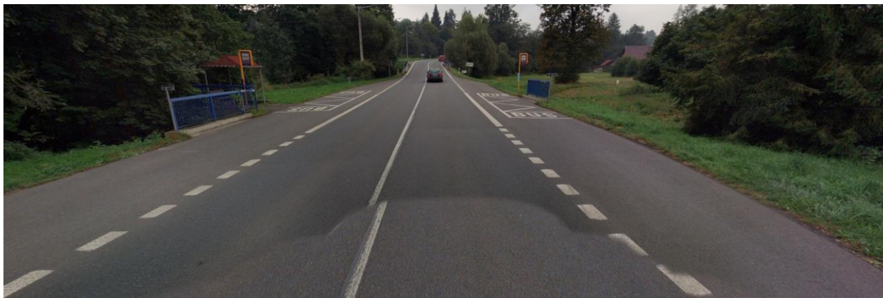
Obr.1) Řešená oblast – pohled od viaduktu směr centrum
