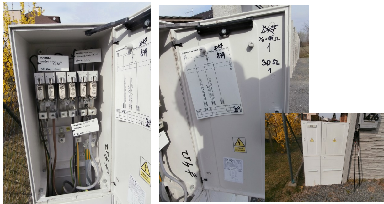
Pohled na pojistkovou skříň SS100 č. 879 a její zapojení.
